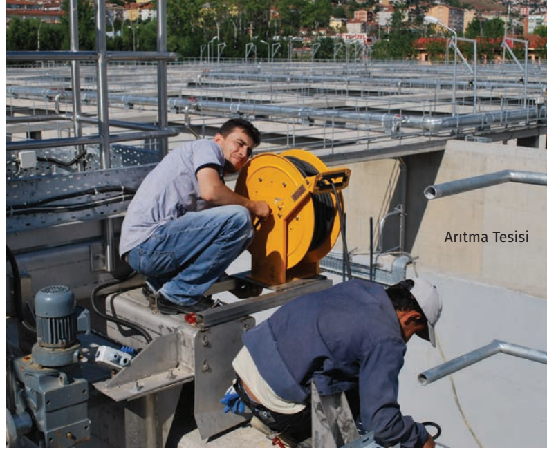
Vinçlerde Kullanılan Yağ ve Enerji Aktarım Tamburu
